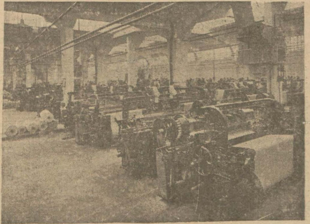
Bakırköy fabrikasının dahilinden bir görünüşü
